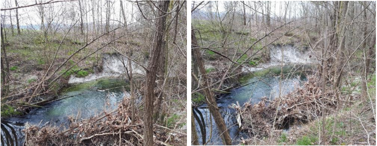
Figura 1-10 Scarsa manutenzione della vegetazione all'interno della vasca di laminazione lungo il torrente Bevera.
