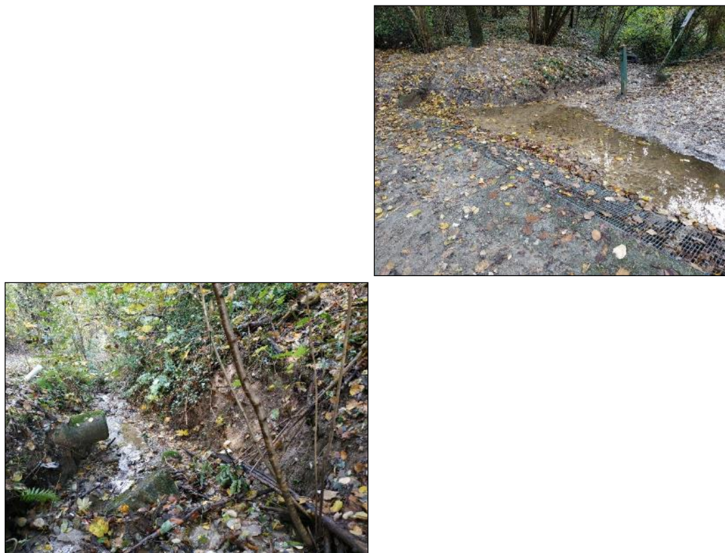
Figura 9 particolare dissesto della roggia e degli organi di intercettazione
