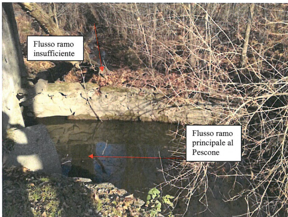
Figura 4 – Confluenza dei reticoli di drenaggio diretti al torrente Pescone. Si osserva la soglia con foro atta a limitare le portate affluenti da nord e probabile causa delle insufficienze segnalate lungo tale ramo.
