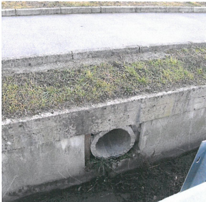
Figura 13 – Esempio di scarico al fosso di drenaggio delle acque meteoriche della zona industriale di Oggiono.
