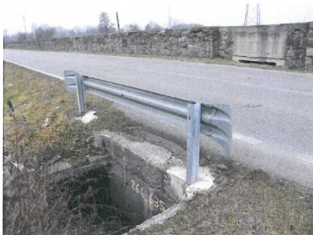
Figura 11 – Muro di confine del sedime ferroviario in corrispondenza di un tombotto con apporti dalla sede stradale (tramite l'apertura rettangolare nel muro) e dal canale di drenaggio delle portate meteoriche della zona industriale di Oggiono.
