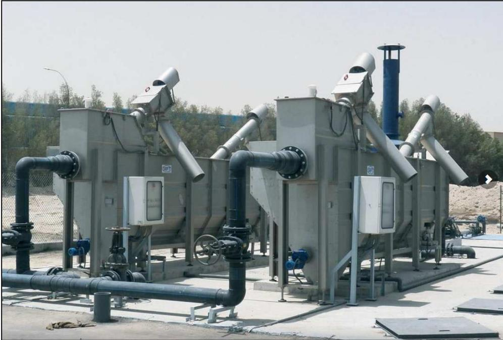
*Figura 2 Immagine fotografica esemplificativa dell'impianto compatto di grigliatura, dissabbiatura e disoleazione proposto in sostituzione di quello previsto in progetto.*
