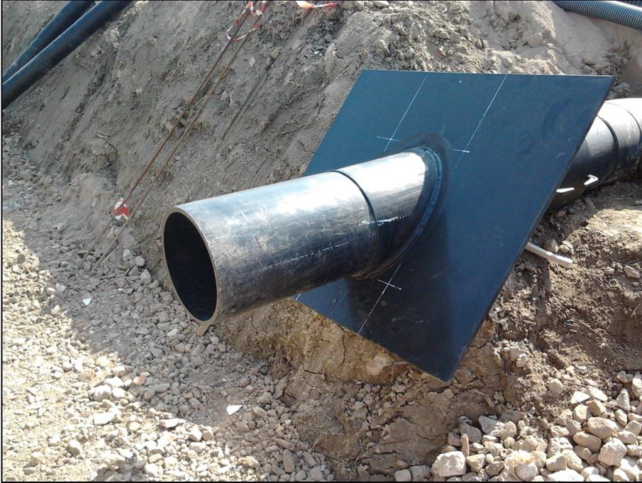
Figura 3. Esempio di pezzo speciale di giunzione tra scarico condotte PEAD e guaina di rivestimento.
