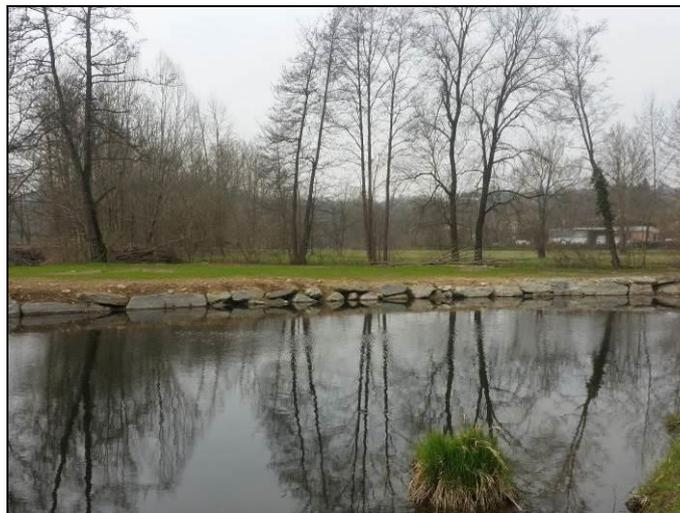
*Figura 1 – Ripresa fotografica della scogliera già esistente in sponda destra del fiume Lambro*
