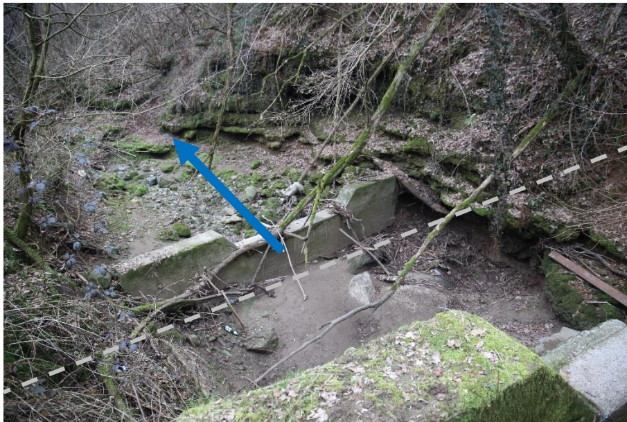
Figura 22: asse della futura opera di sbarramento in corrispondenza delle attuali briglie. Notare il ceppo stratificato in destra idrografica. Linea tratteggiata=asse longitudinale.
