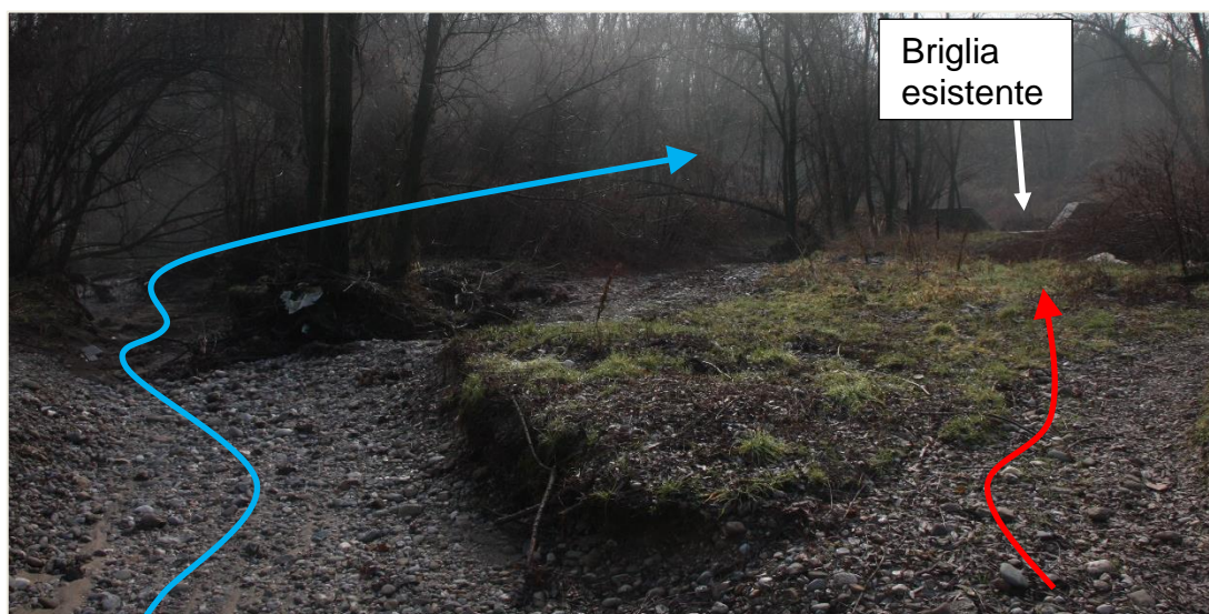
Figura 31: situazione inerente la briglia aggirata-vista da monte verso valle. Freccia Rossa=antico corso del rio; freccia Blu=corso del Rio attuale, accompagnato da una maggiore erosione dell'alveo.
