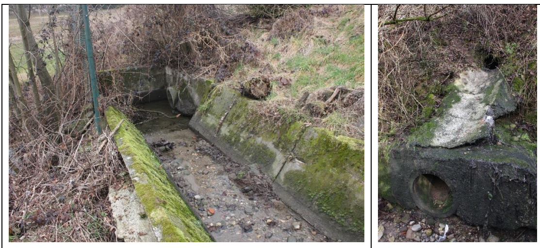
Figura 33: tubazioni afferenti la fognatura comunale. A sinistra l'immissione nei pressi del campo sportivo di Besana mentre a destra la tubazione di troppo pieno a sud del laghetto.
