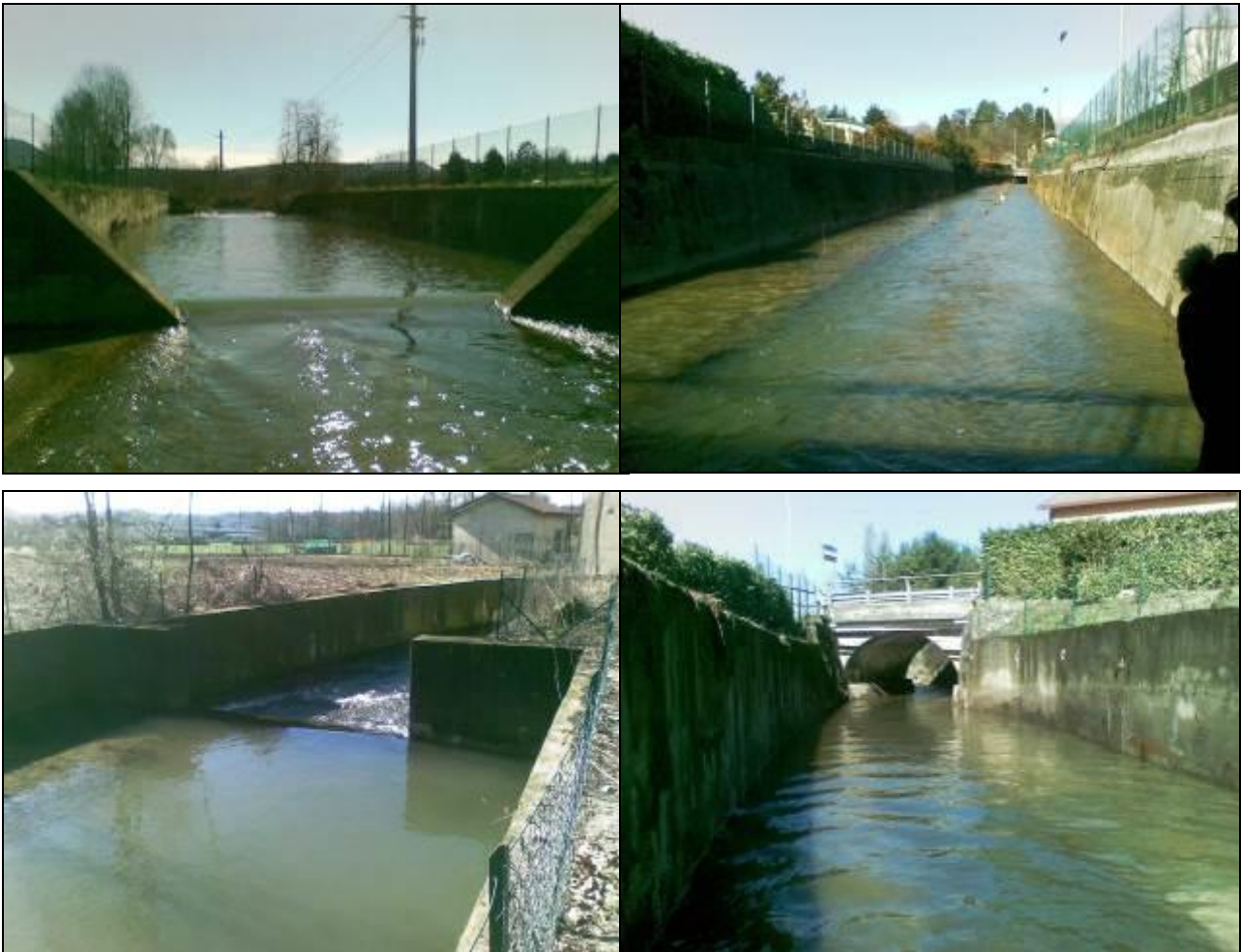
Figura 13 – (in alto) a) vasca di sedimentazione della Bevera e b) tratto canalizzato a valle; (in basso) a) vasca di sedimentazione del Gandaloglio e b) tratto canalizzato a valle
