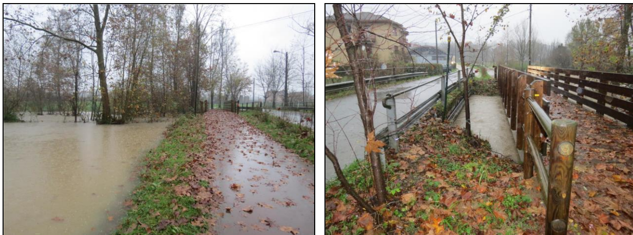
Figura 26 – Ripresa fotografica del 15/11/2014, ore 16.30 circa, del ponticello stradale e ciclopedonale di via Cattafame sulla Bevera di Veduggio. Si noti l'esteso allagamento presente a monte degli attraversamenti e il deflusso "in pressione" al di sotto di questi (fonte: nota tecnica del 16/12/2014, Associazioni "Orrido di Inverigo" e "Le contrade")
