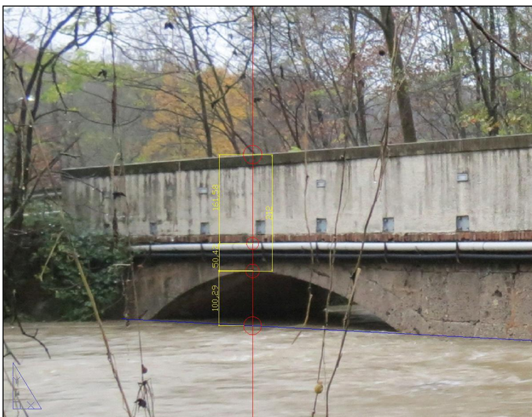
Figura 16 – Ripresa fotografica del ponte di Fornacetta in data 15/11/2014 ore 17.00 circa e stima dei livelli idrici (fonte: nota tecnica del 16/12/2014, Associazioni "Orrido di Inverigo" e "Le contrade")
