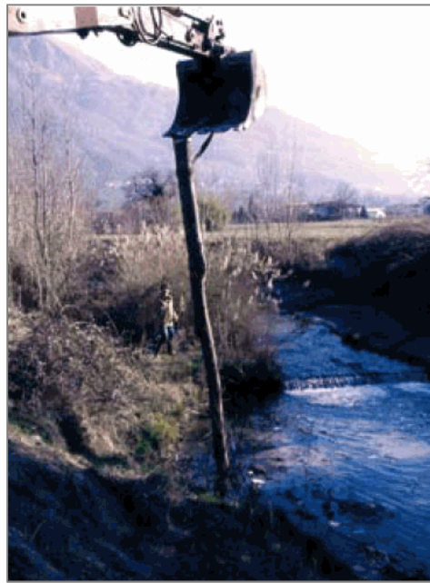
Figura 25 – Infissione verticale di tronchi tramite l'utilizzo a spinta della benna del mezzo meccanico (in opera)
