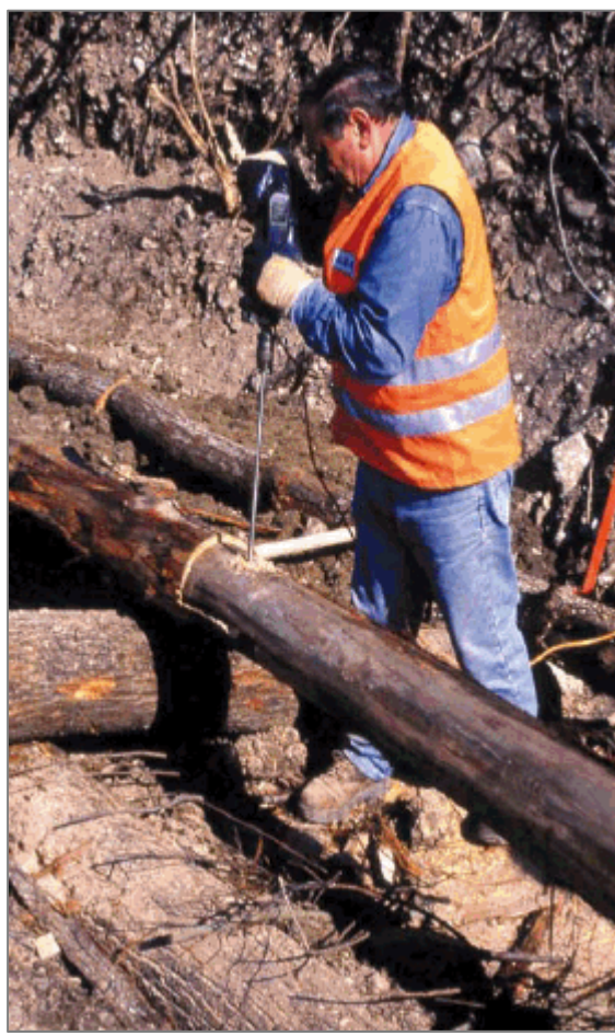
Figura 29 – Esecuzione del foro per la chiodatura
