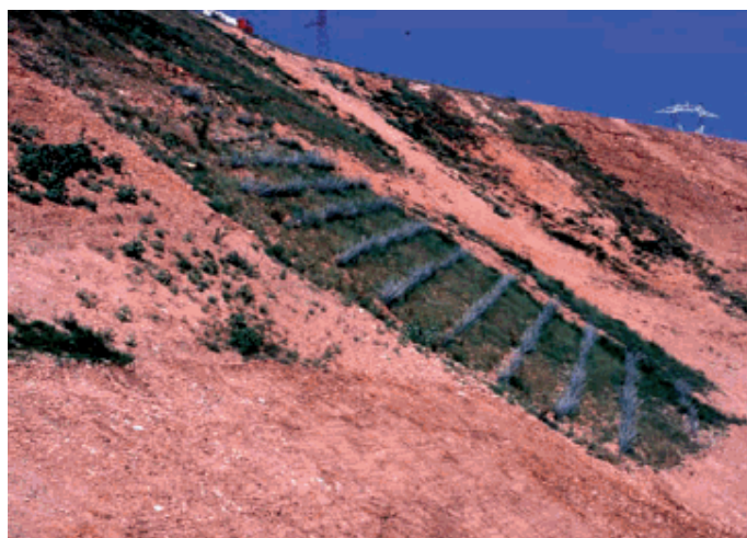
Figura 21 – Esempio di disposizione in file delle talee
