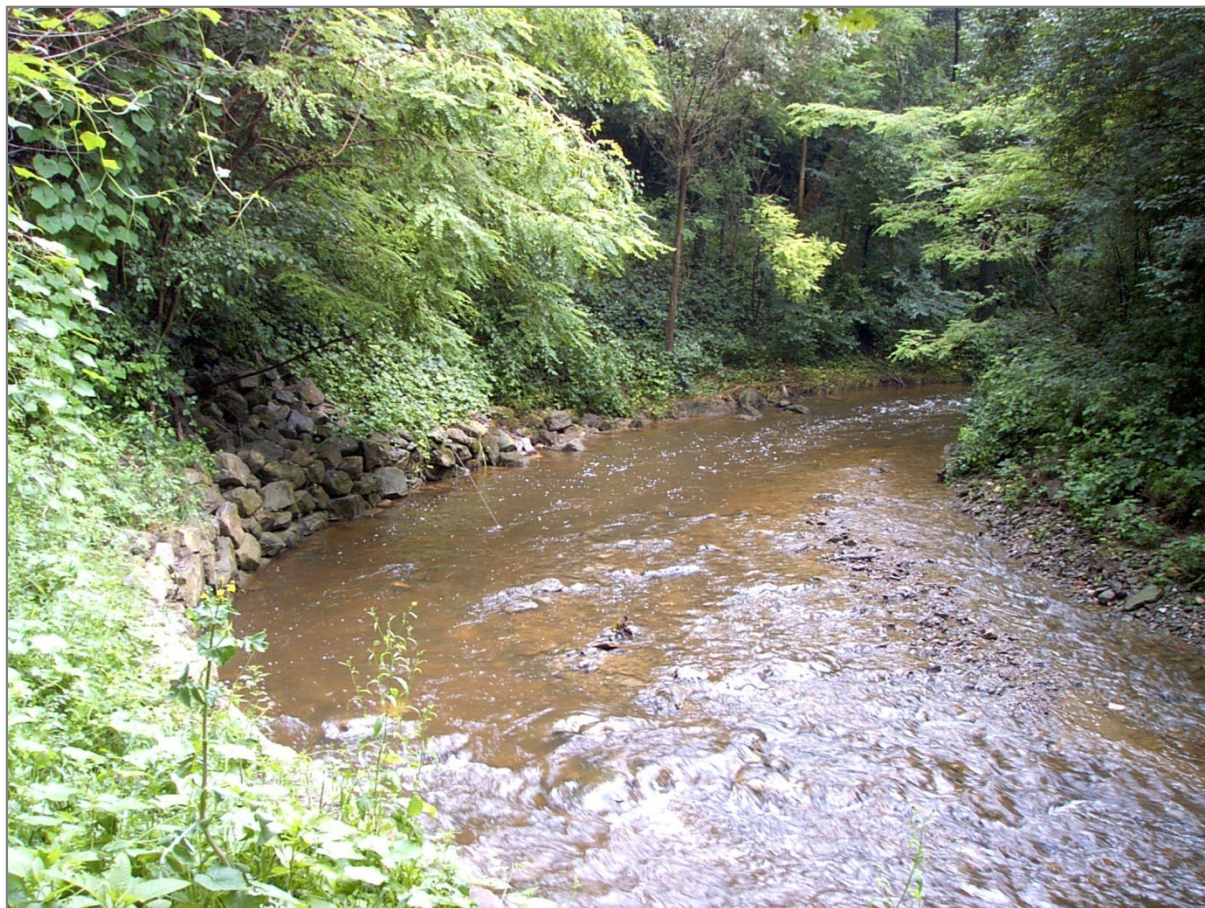
Foto 21 – Scogliera longitudinale da ripristinare (foto del 2009)
