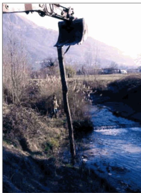
Figura 19 – Infissione verticale di tronchi tramite l'utilizzo a spinta della benna del mezzo meccanico (in opera)
