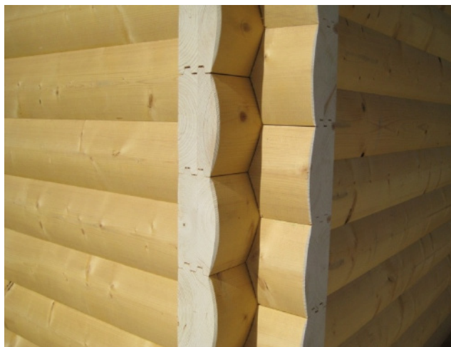
Dettaglio dell'incastro tra pareti esterne con metodo standard
