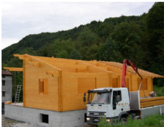
Immagine esemplificativa della fase di costruzione delle pareti esterne
