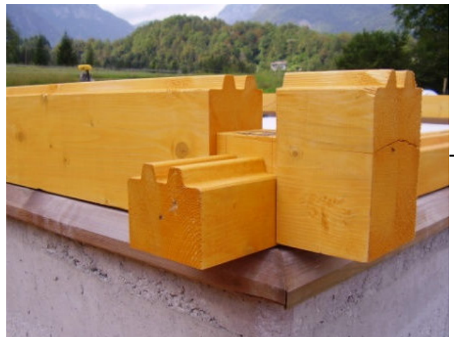
Dettaglio delle travi di appoggio alla platea di fondazione
