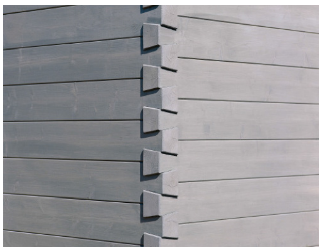
Dettaglio dell'incastro tra pareti esterne con metodo "Tirolerschloss"
