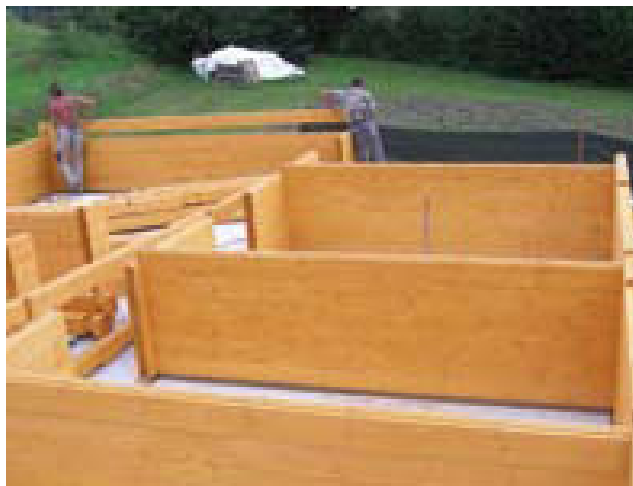
Immagine esemplificativa della fase di costruzione delle pareti
