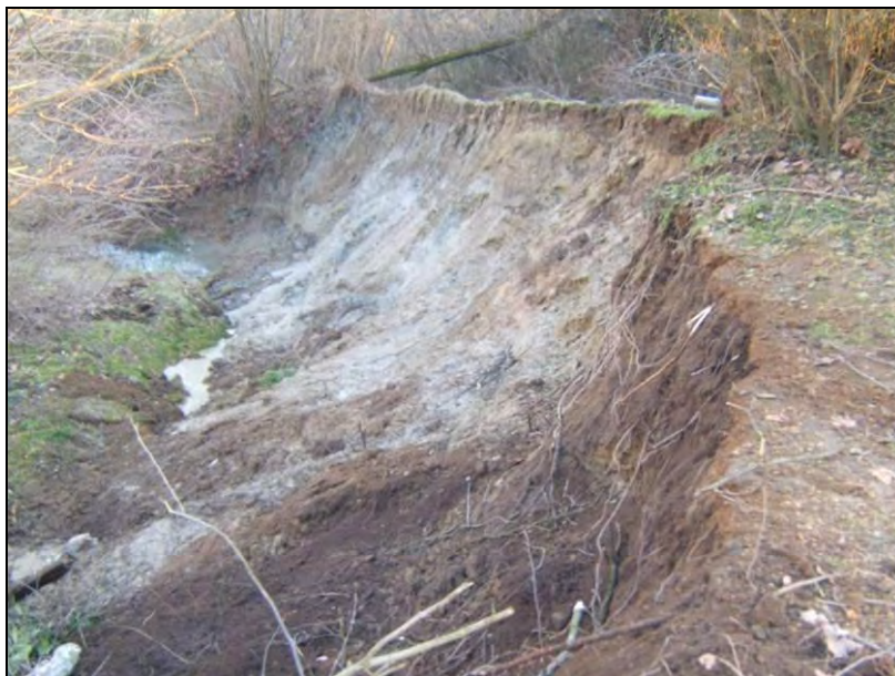
Figura 18 Scarpata di frana nel tratto che ha interessato la strada campestre.
