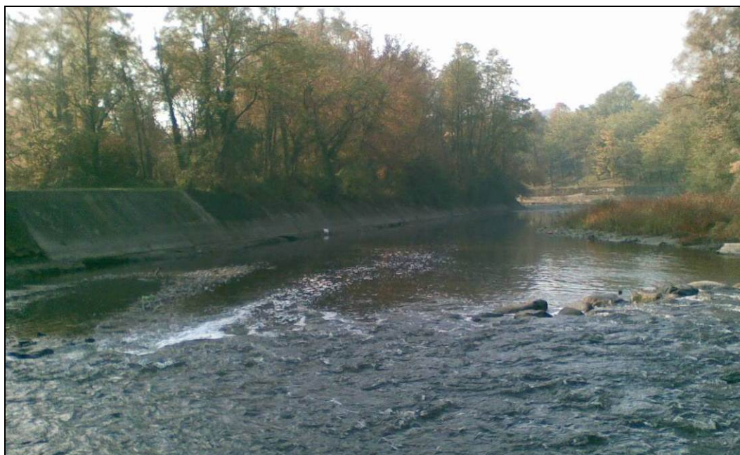
Figura 42 – Vista dalla briglia verso valle delle artificializzazioni di sponda con lastroni in calcestruzzo
