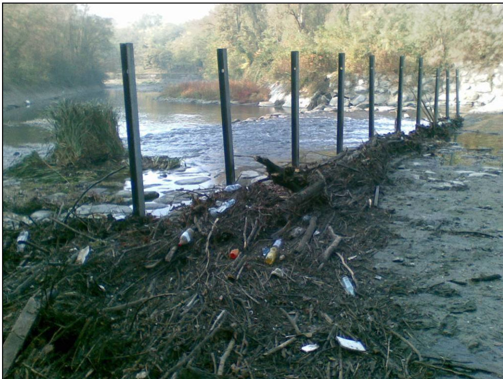
Figura 63 – Vista da monte del pettine della briglia sul Lambro
