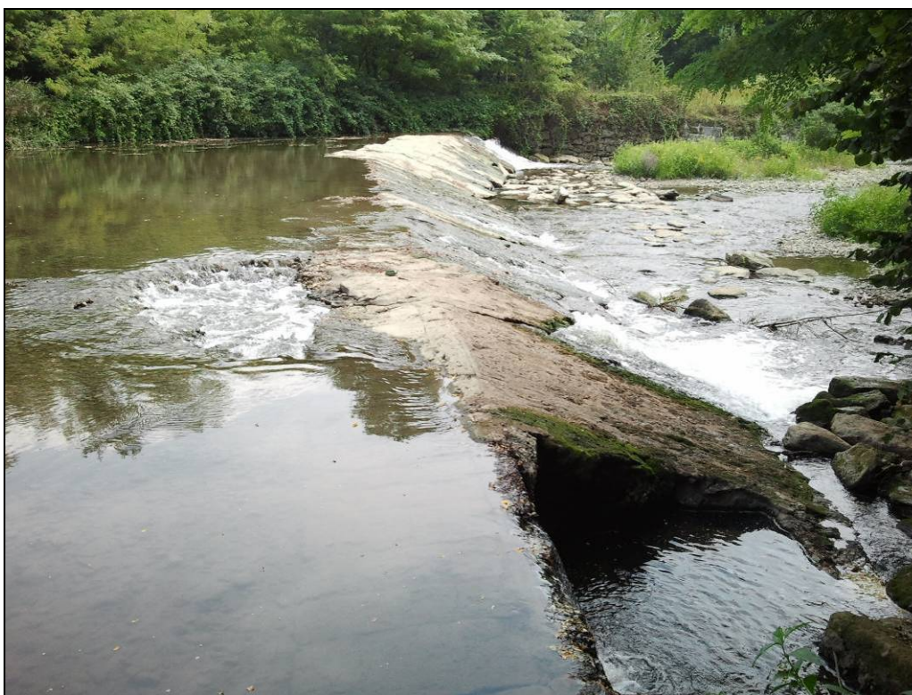
Figura 47 – Vista del tratto di scivolo crollato
