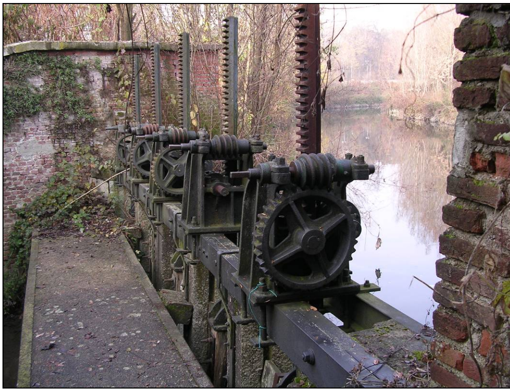
Figura 78 – Vista del gruppo di paratoie a monte della traversa
