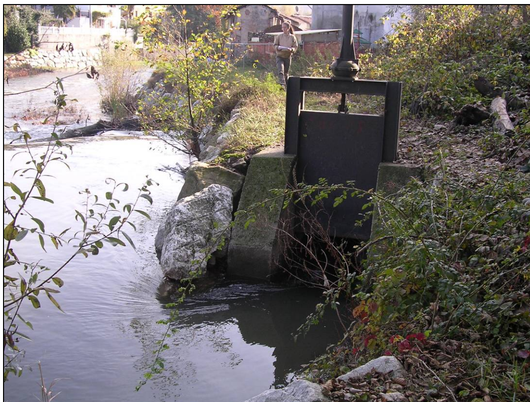
Figura 59 – Vista della paratoia di alimentazione della roggia derivata dal Lambro in sponda destra
