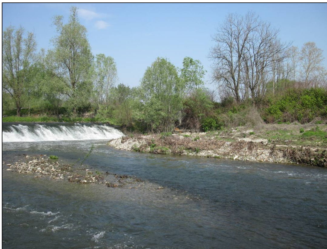
Figura 80 – Vista da valle della traversa e della sponda sinistra occupata dai sedimenti
