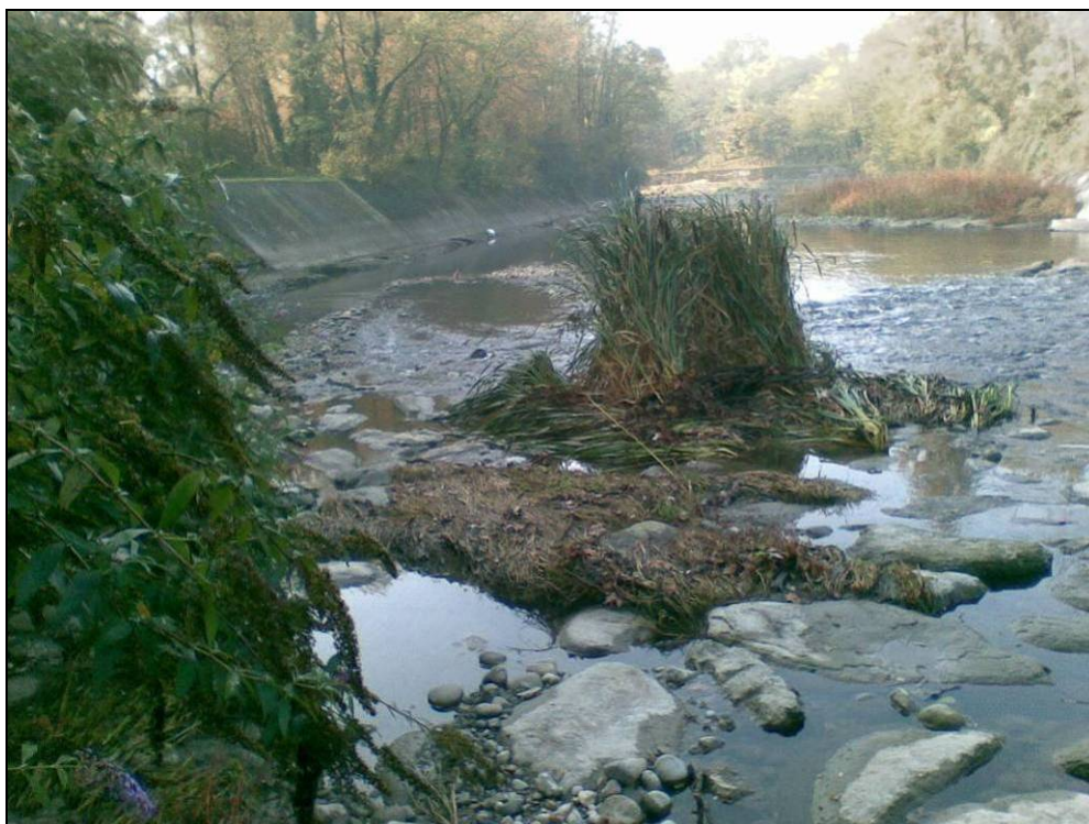
Figura 66 – Vista verso valle della sponda sinistra in lastroni e del fondo in massi a valle della briglia
