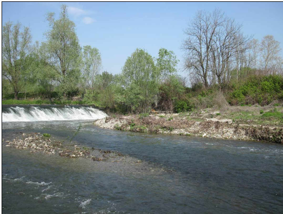
Figura 49 – Vista da valle della traversa e della sponda sinistra occupata dai sedimenti
