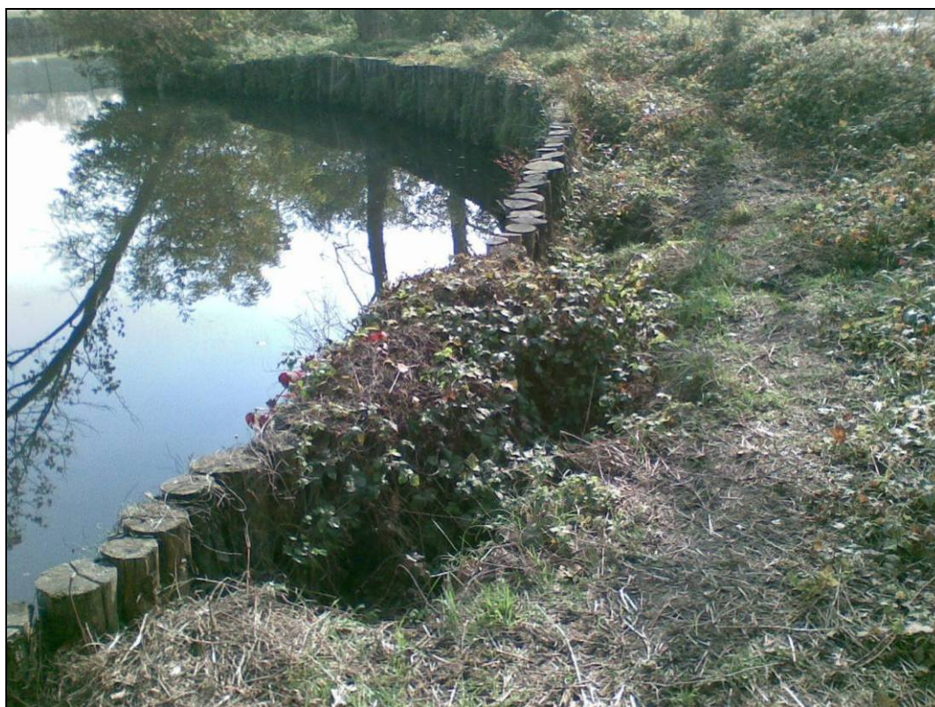
Figura 2 – Vista della palificata in sponda destra del fiume
