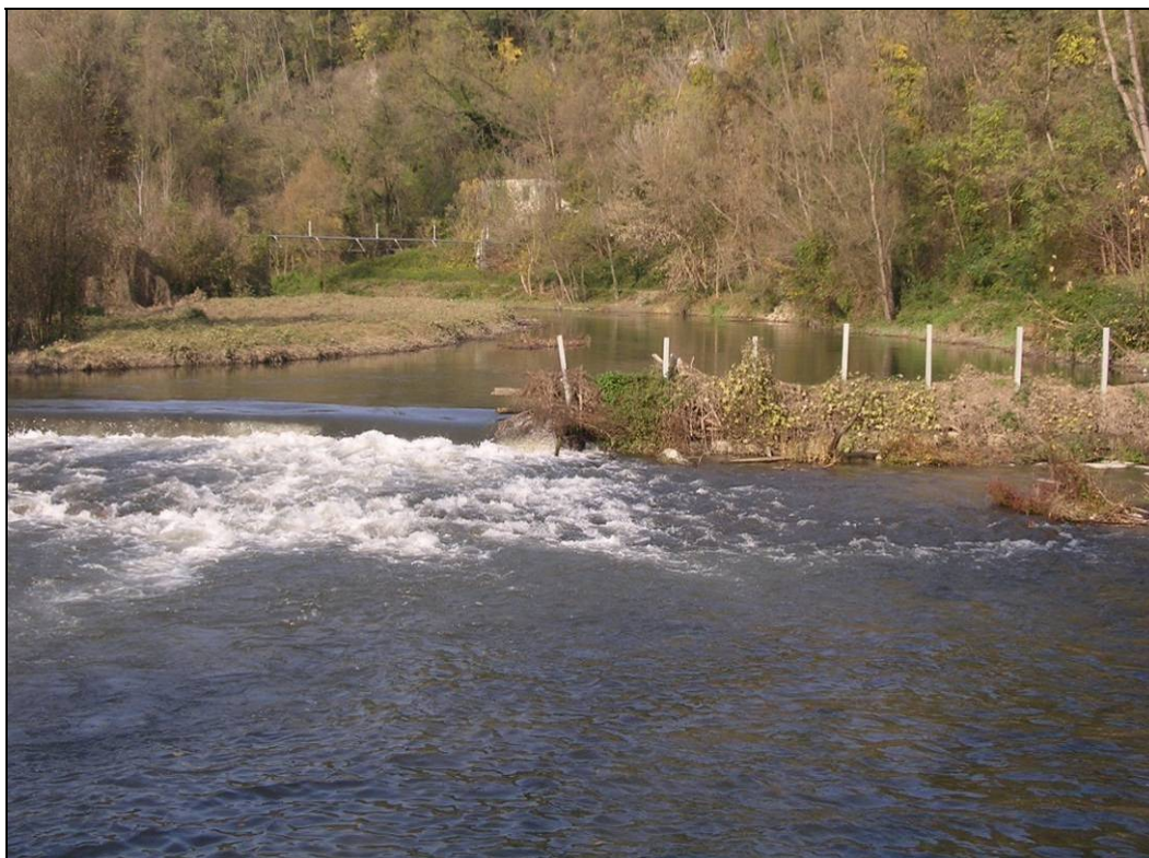
Figura 43 – Briglia selettiva a pettine (vista da valle) e accumulo di sedimenti a monte
