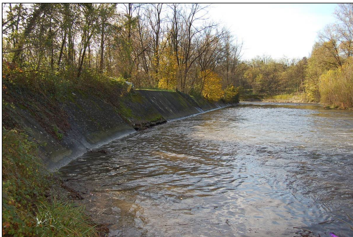
Figura 67 – Dettaglio della sponda sinistra in lastroni, con vista di un punto ammalorato
