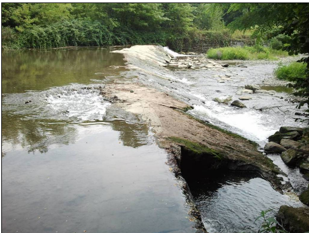
Figura 75 – Vista del tratto di scivolo crollato
