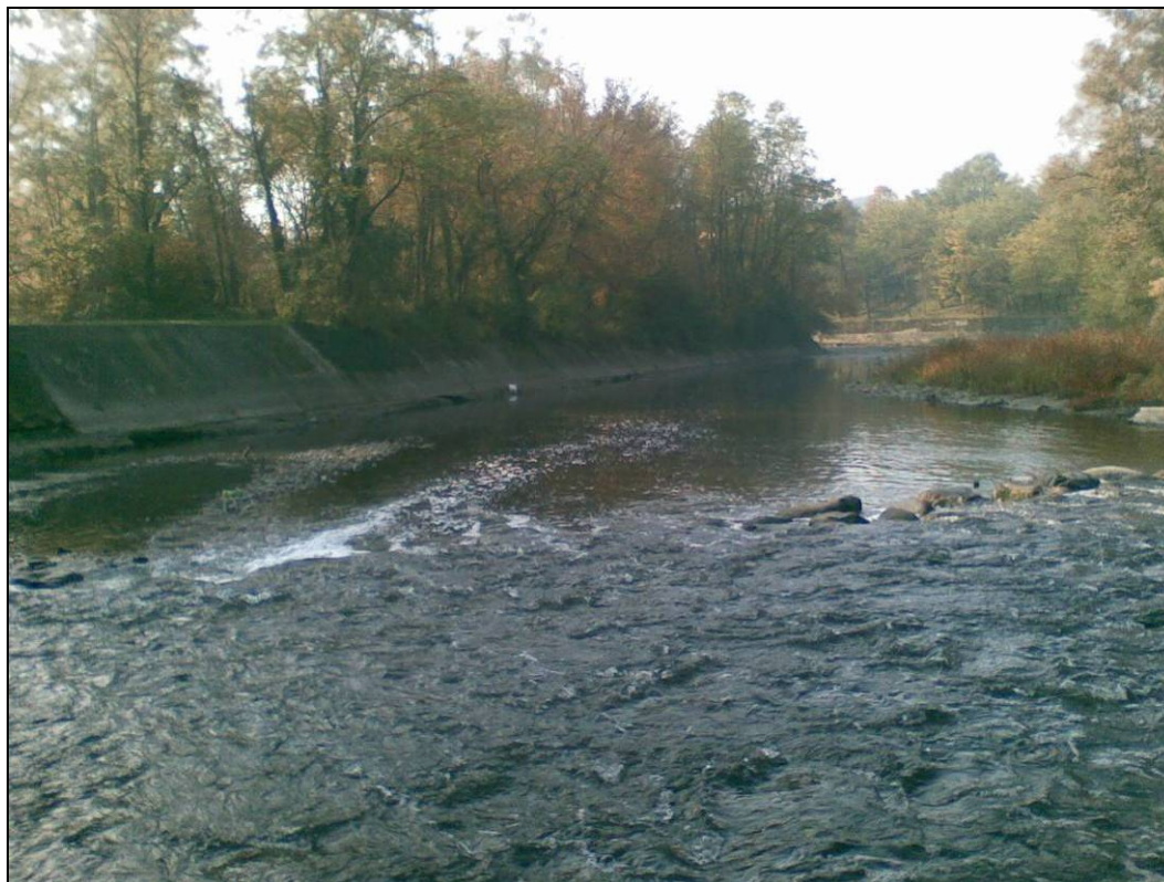
Figura 7 – Vista verso valle dalla briglia, delle artificializzazioni di sponda con lastroni in calcestruzzo
