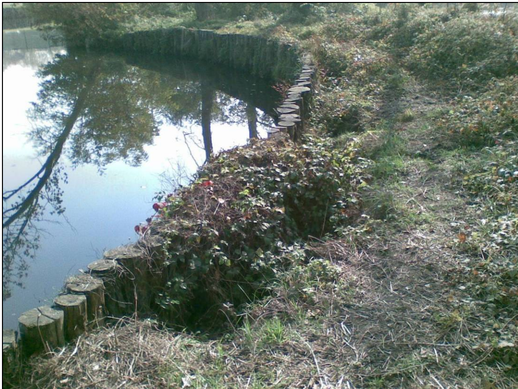
Figura 36 – Vista della palificata in sponda destra del fiume
