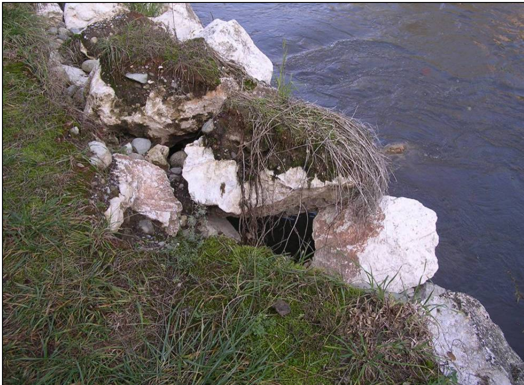
Figura 4 – Dettaglio dello stato di cedimento dell'argine in massi
