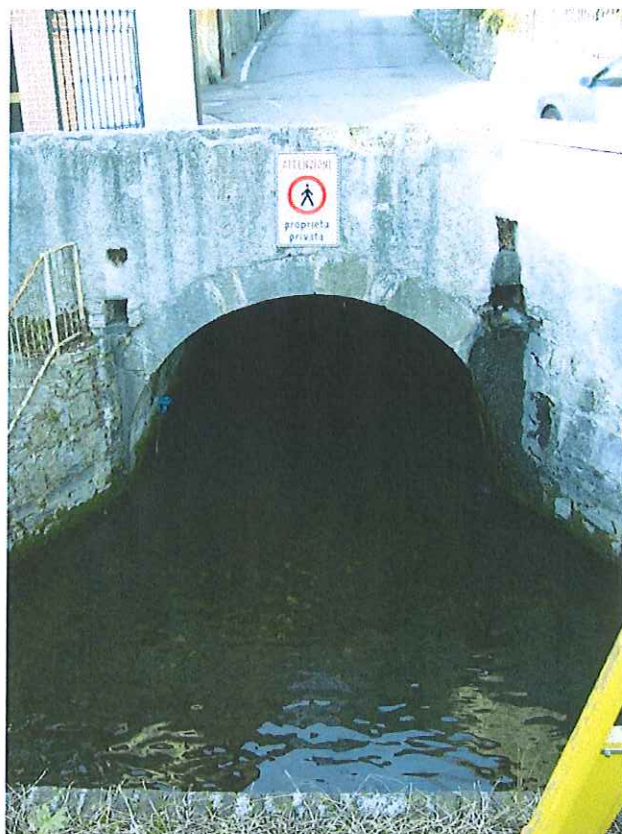
Figura 7.3 – Sbocco del tratto tombato presso la Frazione di Stallo
