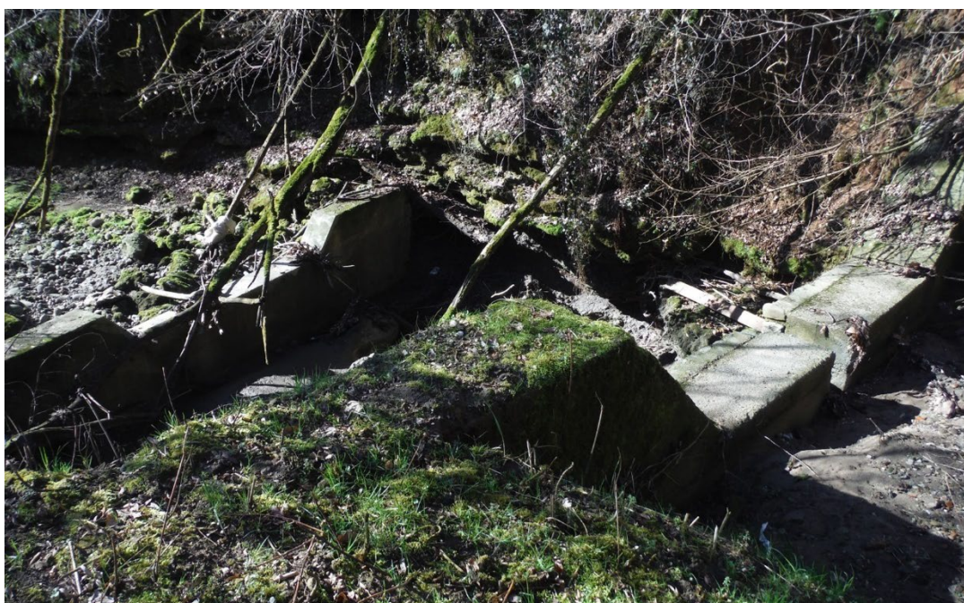
Figura 4: briglia di consolidamento esistente all'altezza del cimitero della frazione Calò, Comune di Besana in Brianza
