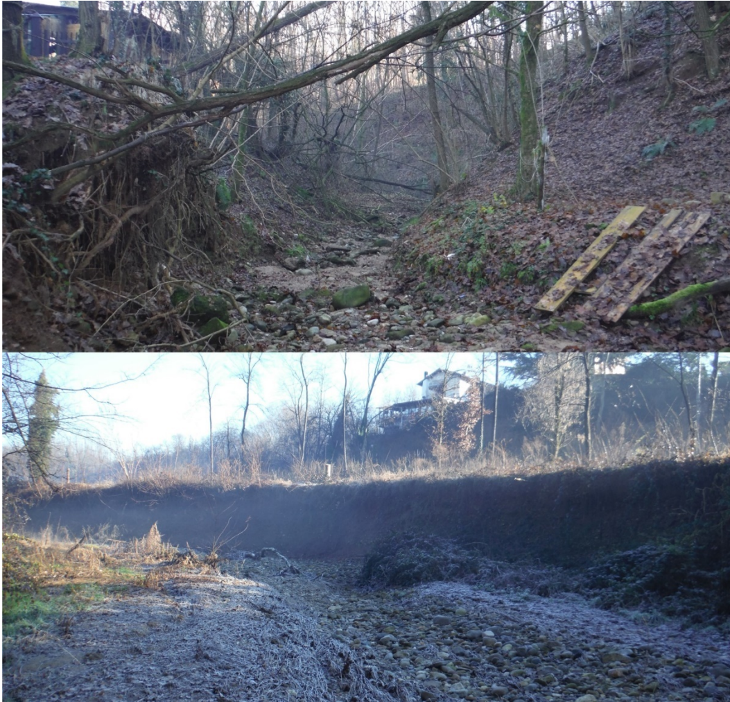
Figura 6: sezione tipica del Torrente Brovada nel tratto a valle della briglia di consolidamento (alto); vista da valle della curva destrorsa del torrente in località Cascina Siberia, Comune di Triuggio (basso)
