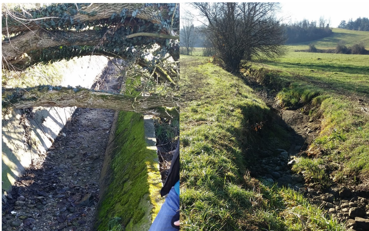
Figura 2: canalizzazione del Rio Brovada nei pressi del centro sportivo di Besana in Brianza (sx) e tratto interamente naturale che attraversa i campi a valle
