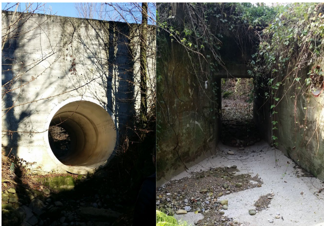
Figura 3: vista da valle dell'attraversamento di Via Borromeo (sx) e vista da monte dell'attraversamento di Via della Valle (dx)
