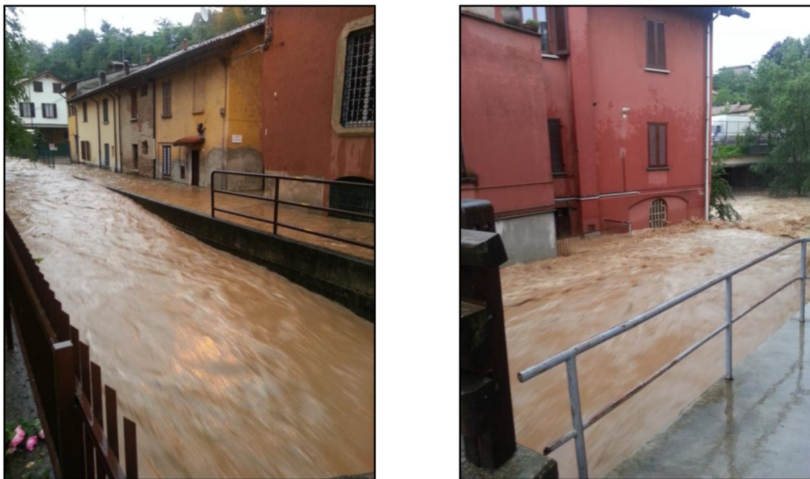
Figura 53: tratto artificializzato del Rio Brovada a monte (sx) e valle (dx) del ponte di Piazza Boretti, piena di giugno 2014
