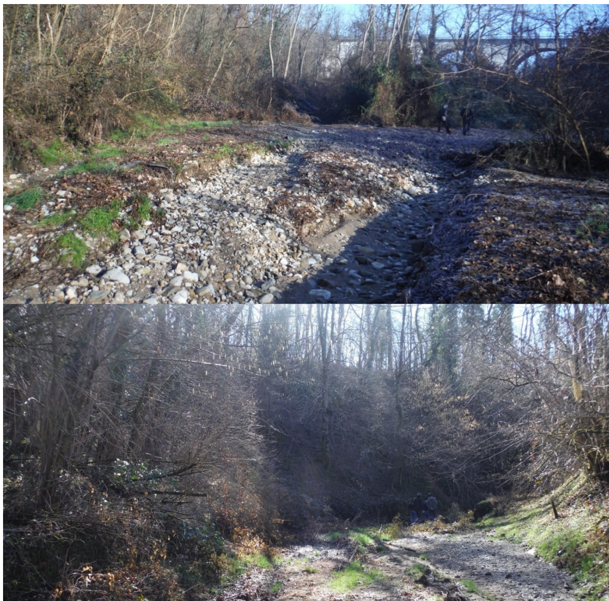
Figura 7: alveo del Rio Brovada a valle del ponte della ferrovia, visibile sullo sfondo (alto); vista da valle del punto indicato nel PFTE come sede della futura opera di regolazione di valle lungo il torrente (basso)
