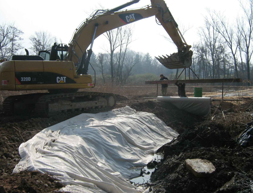
Esempi posa telo bentonitico
