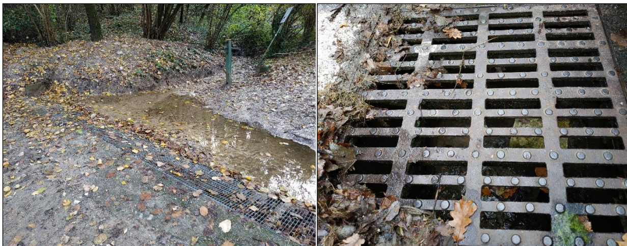
Figura 2.3 - Organi di intercettazione di liquidi e solidi in adiacenza a via Garibaldi
