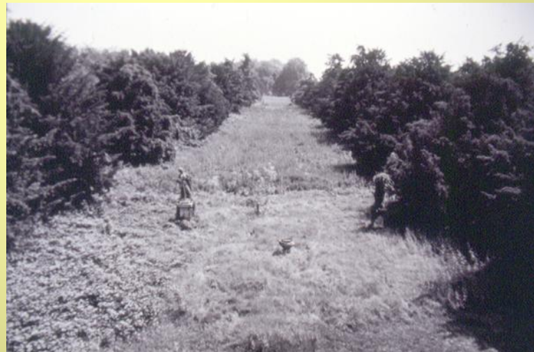
Cesano Maderno, Palazzo Borromeo Arese, asse centrale, ante intervento
