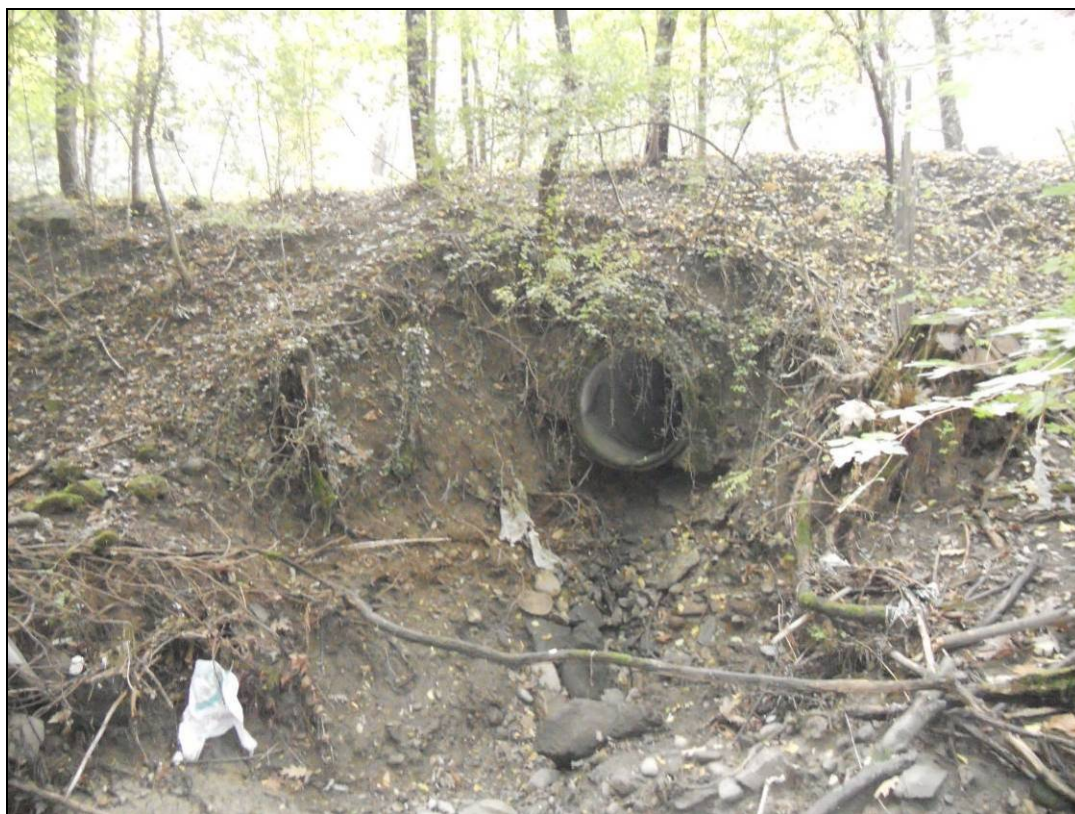
Figura 33 – Sfioratore fognario sull’Orrido
